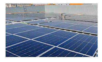
公司有7500平方的光伏发电设备,年发电量132万度,有效的降低了生产成本并为绿色环保贡献自己的力量。
